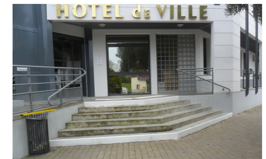
mains courantes à prolonger en bas d'escalier
